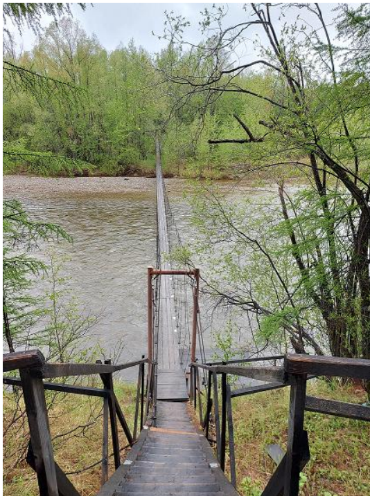
Рисунок 3 Подвесной мост через р. Хасын
